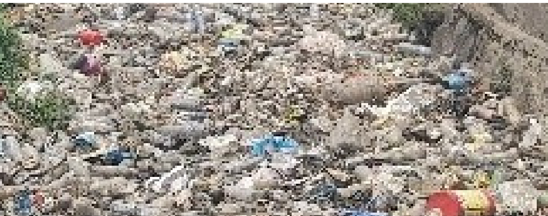
Pendant travaux de curage Valée Sud Abattoir
