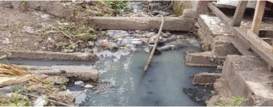
Pendant travaux de curage Transversal/ Salongo
