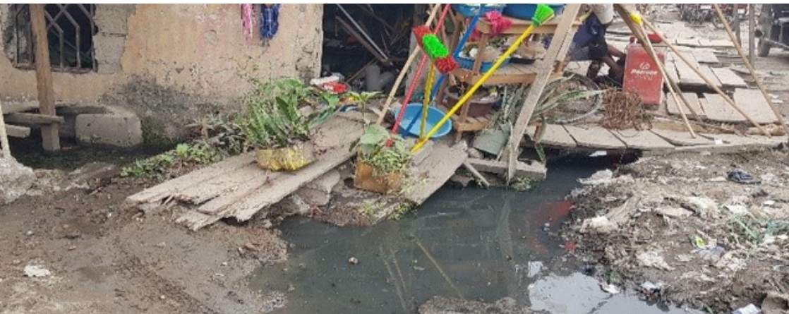
Pendant travaux de curage Mwepu/ N'danu
